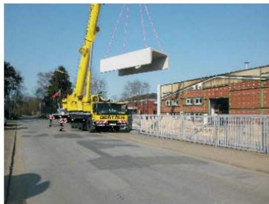
Figuur 12 installatie Revisions Rigole middels een kraan
