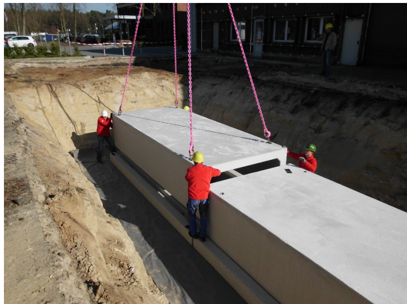
Figuur 1 Installatie van de Revisions-Rigolen in Emsbüren
