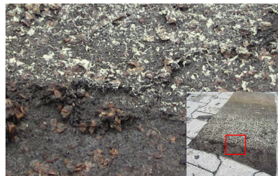
Figuur 8 Bovenste 2 lagen van een stuk afgesneden geotextiel
