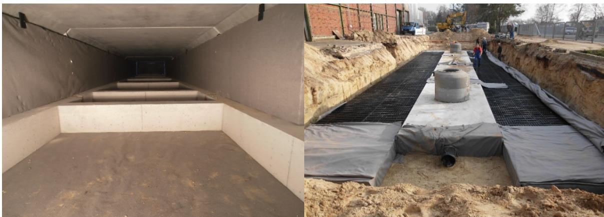
Figuur 3 Binnenkant van de Revisions-Rigolen met aan de zijkanten de infiltratiekratten geïnstalleerd (l) en de buitenkant inclusie mangaten en omliggende kratten in Emsbüren (r)
