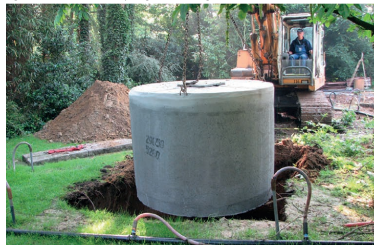
Figuur 4: Prefab beton opslagtank.
