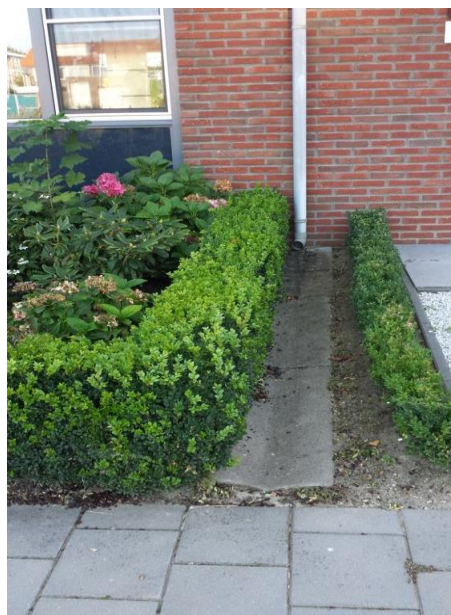
Figuur 8 Voorbeeld afvoergoot (Rainproof, 2018)
