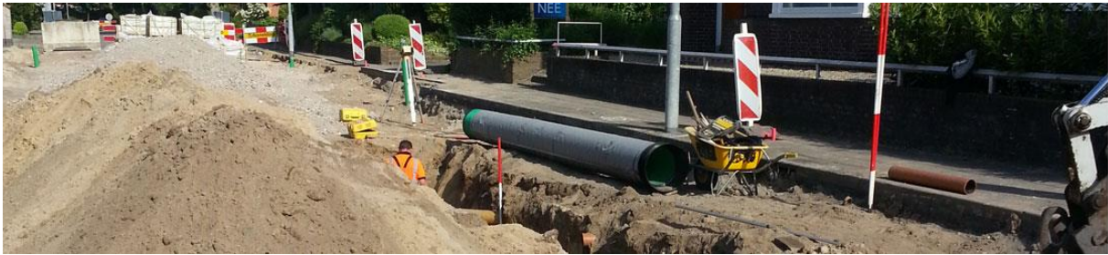
Figuur 11: Aanleg horizontaal IT buis Bron: (Wavin, 2018)
