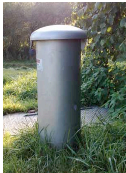
Figuur 6 Voorbeeld filter op bergbezinkbassin
