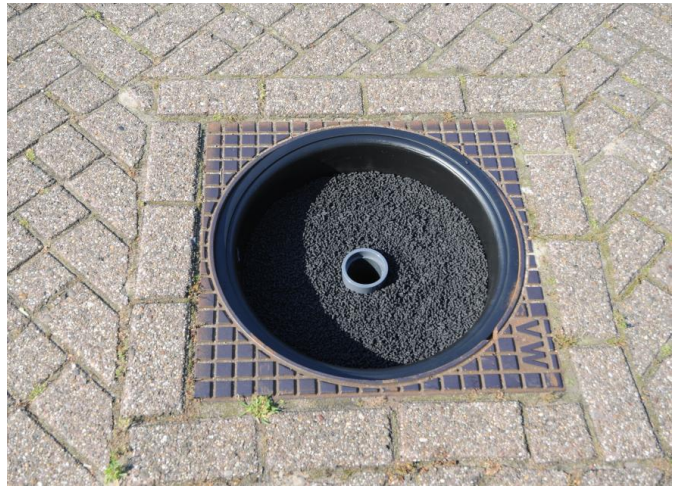
Figuur 16 Binnenwerk open putdeksel. Bron: (IE Systems, 2018)
